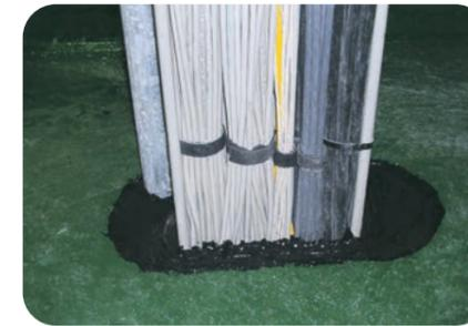
FIRE KORESEAL QS119R은 1액형 방화용 실란트로서, 비교적 좁은 관통 부위인 CABLE, PIPE, DUCT 등에 시공되어, 불길의 급속한 확산과 유해 가스를 차단해 주며, 내구성, 내열성, 내한성이 우수하고 방수, 방습 및 방음 효과를 발휘하도록 설계된 KS G-25HM, F-25HM 인증 및 FILK 인증을 획득한 제품입니다.
