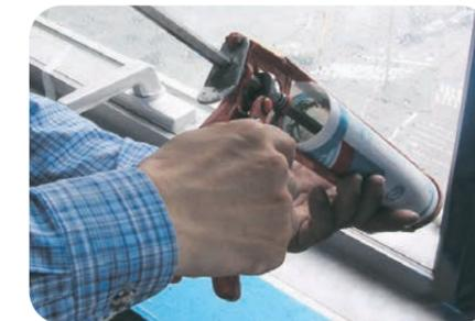
코레실 SL819는 중성경화형의 1액형 실리콘 실란트로서, 부착력 및 강도가 뛰어나며, 구조적 힘을 요구하는 스트락츄얼 글레이징용(SSG)에 적합하게 설계된 KS G-25HM, ASTM C 1184 획득 제품입니다.
